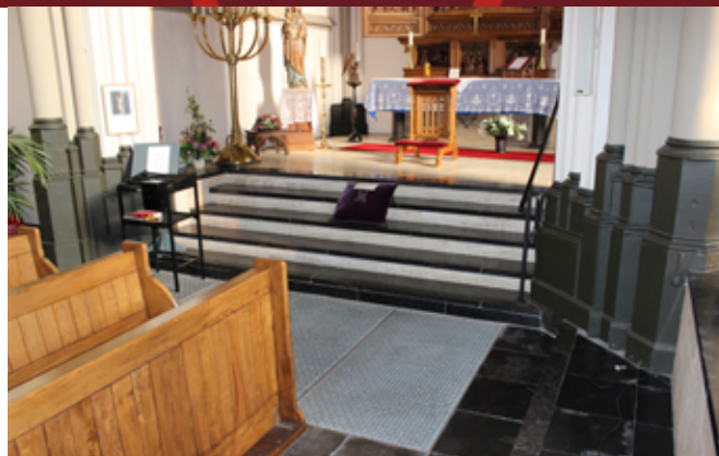
Uitblaas van de heteluchtverwarmingsinstallatie
