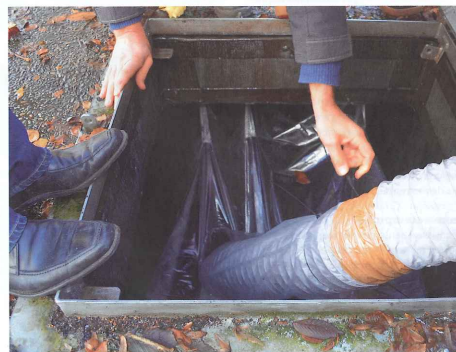
Veldbezoek aan rioolgemaal Moordrecht.
